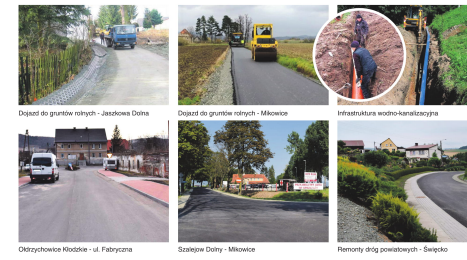
Dojazd do gruntów rolnych - Jaszkowa Dolna, Dojazd do gruntów rolnych - Mikowice, Infrastruktura wodno-kanalizacyjna, Odkrzyżkowie Kłodzkie - ul. Fabryczna, Szarekpw Dolny - Mikowice, Remonty dróg powiatowych - Świeżów
